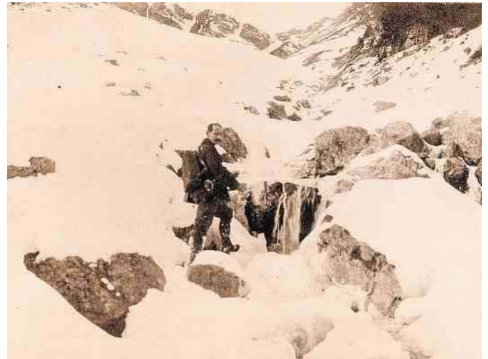
Vorbereitungen zur Fassung der Altsäss-Quelle Malschül in einer historischen Aufnahme vom 14.1.1902.
