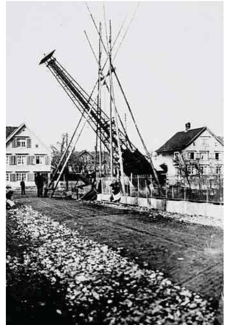
Montage der Mast-Transformatorstation Schulhausstrasse 1903.
