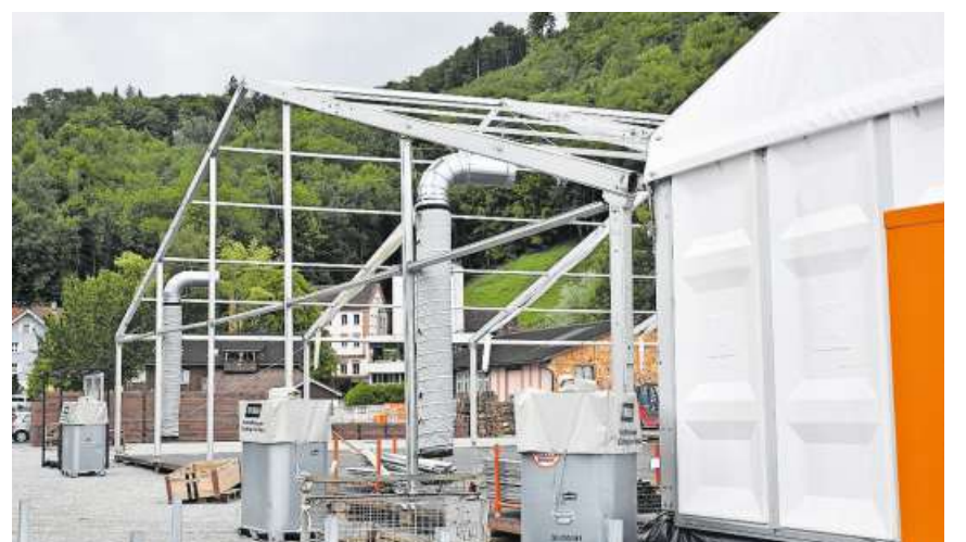
Zeltbauer im Element (von oben nach unten): Am Montag werden die Böden der Messehallen verlegt; am Dienstag wird ein Zeltgerüst aufgebaut; am Mittwoch werden die Zeltblachen für das Dach aufgezogen; am Donnerstag stehen die Wände der Messehallen 1 und 4, und die Zelte für die Messehallen 2 und 3 sind am Entstehen.
