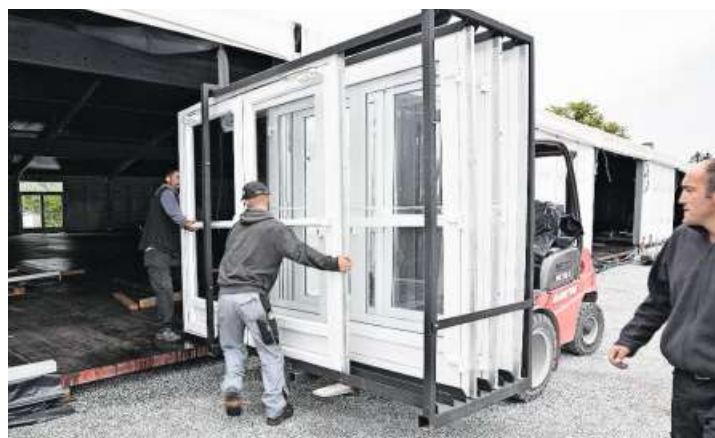
Am Donnerstag werden die Seitenwände sowie die Fenster- und Türelemente der Messehalle 4 (Eventhalle) montiert.
