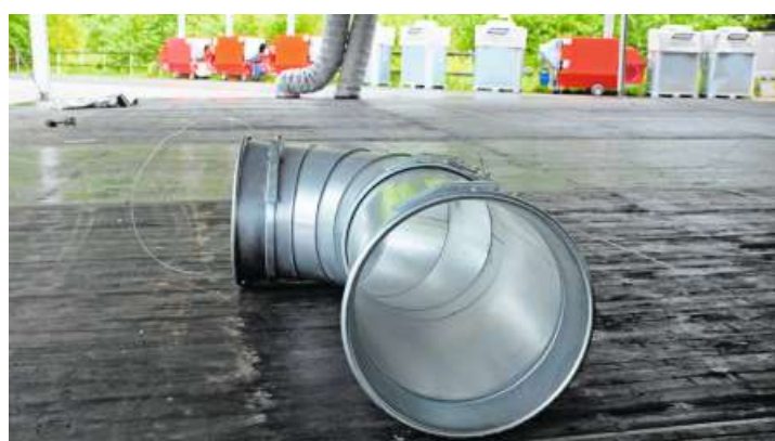
Am Freitag stehen die Heizungsgeräte einsatzbereit, doch zuerst müssen noch Rohre und Heizschlangen im Zelt montiert werden.
