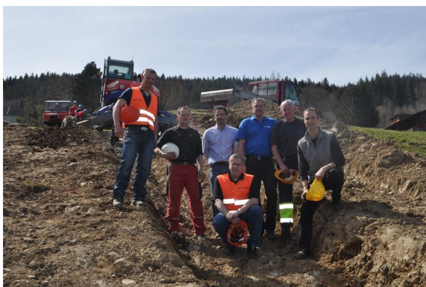
Vertreter des EW Buchs und beteiligter Unternehmen beim Spatenstich
