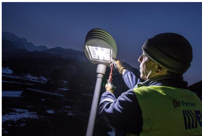
Bruno Inauen bei der Montage einer LED-Leuchte (Bild Peter Fuchs)
