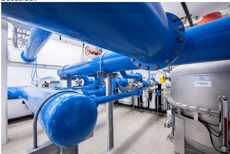
Die neue Gegendruck-Pelton-turbine (rechts im Bild) bringt eine hohe Effizienzsteigerung (Bild Peter Fuchs)
