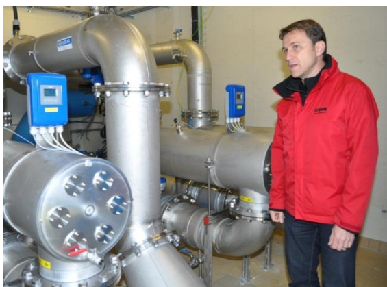
Niklaus Müller erklärt die Funktionen der neuen UV-Trinkwasserentkeimungsanlage im Rahmen der ISO Zertifizierung.
